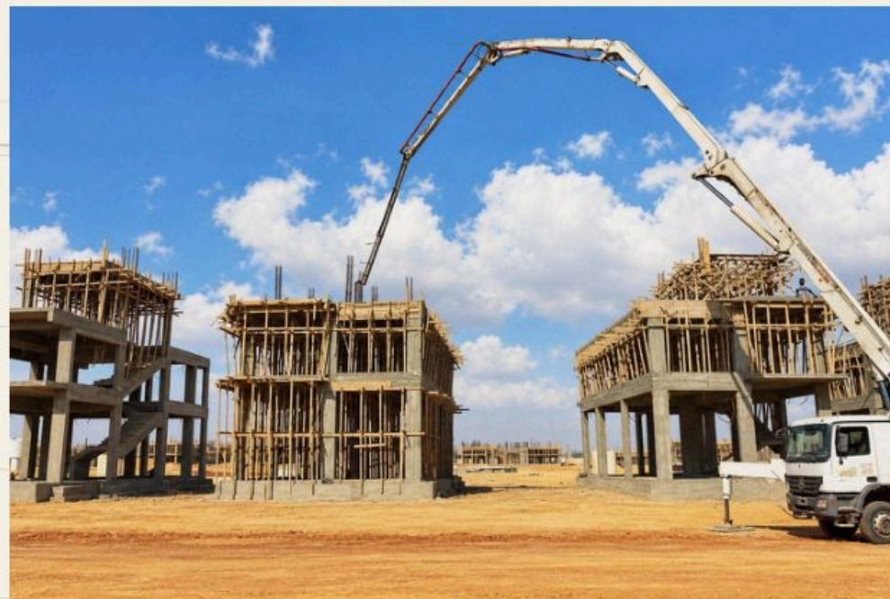
Slab pour along the villa row — on site
